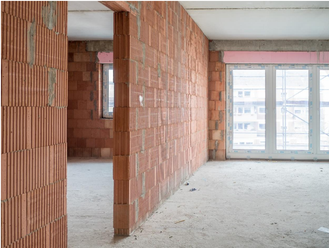
Tragende Innenwände aus Lehmsteinen
