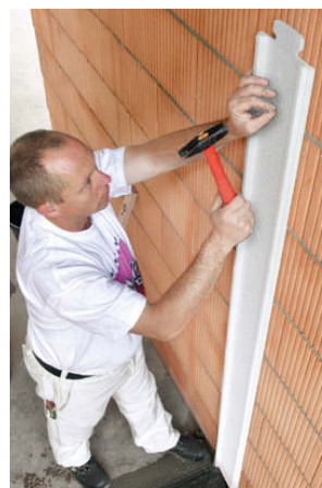
Anbringen der Entkopplungs-Ansatz-Profile (im Bild links EAP-Wand).
