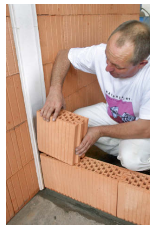
Trockenes Einsetzen (unvermörtelte Fuge zum Profil) der 11,5er Wandplatten.
