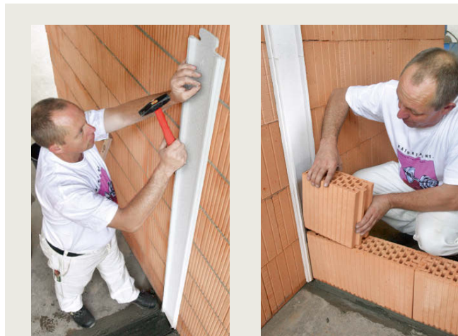
Anbringen der Entkopplungs-Ansatz-Profile (hier EAP-Wand).
