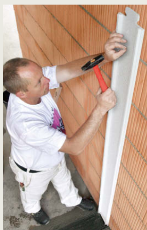
Anbringen der Entkopplungs-Ansatz-Profile (hier EAP-Wand).
