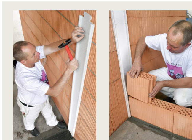
Anbringen der Entkopplungs-Ansatz-Profile (hier EAP-Wand).
